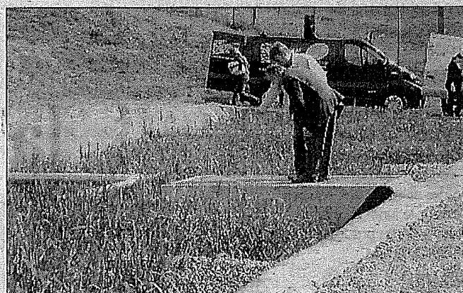
Par ce procédé, une évacuation tous les 10 à 20 ans de la couche de boue est suffisante
