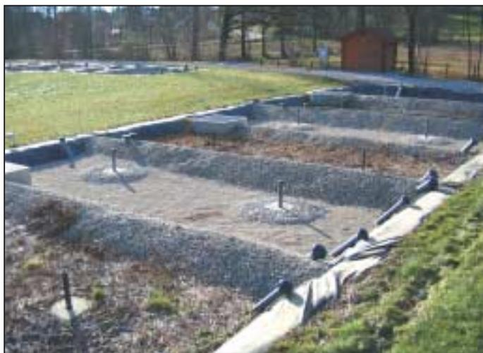
**A** ce jour, Terre d'eaux exploite quatre stations d'épuration par filtres plantés de roseaux - la première a été installée à Colomieu en 1993- et devrait à moyen terme, installer deux autres stations. Ce procédé d'assainissement, particulièrement adapté aux besoins et aux contraintes des petites collectivités, est issu des recherches menées par le CEMAGREF (Centre pour l'étude du machinisme agricole du génie rurale des eaux et forêts).
