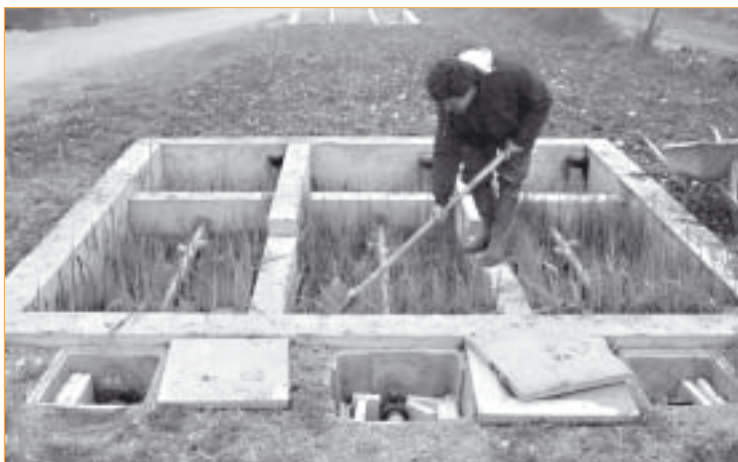
▼ Photo 1 – Vue générale des filtres du 1 er étage dans une ferme de Côte-d'Or.
