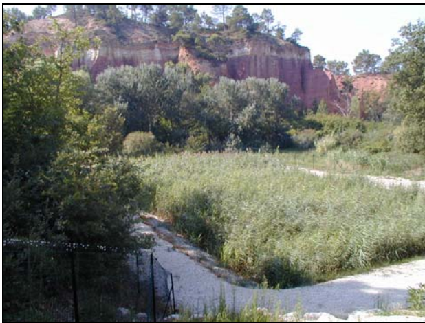
Station de Roussillon (84) – 1200 EH – Station de traitement des eaux usées domestiques conçue par SINT
