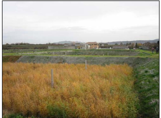
SIA du Pays d'Albon (26) – 13 000 p.e. - Phragmicompostage® sewage sludge treatment plant
