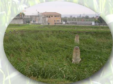
Traitement des boues SIA d'Albon (26)
