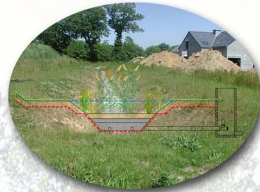
Fossé de rétention drainé à La Chapelle des Fougeretz (35)
