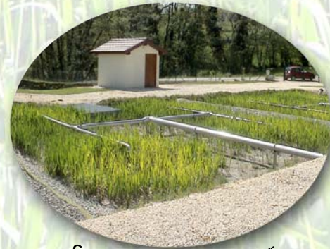
Station d'épuration par filtres plantés de roseaux à Epersy (73)
