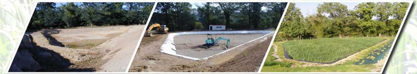
Suivi de chantier : station d'épuration de Salt en Douzy (42)
