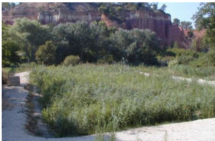
Filtre planté de roseaux
