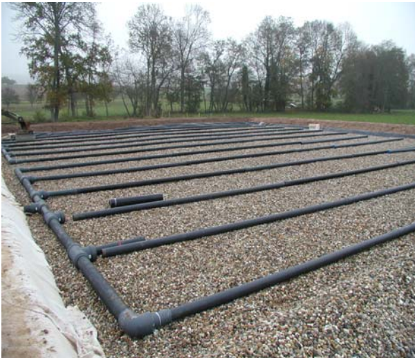
Le deuxième étage de traitement. (en cours de réalisation)
