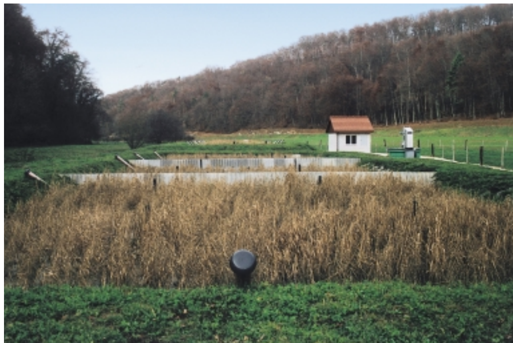
Une vue d'ensemble de la station avec le premier niveau de filtres, le petit bâtiment d'exploitation, le dégrilleur (à dr.) et plus loin le deuxième niveau de filtres également planté de roseaux.
