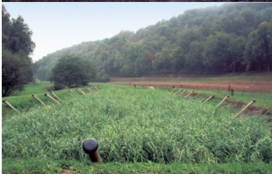
En haut: le 1 er niveau de filtres alors que les eaux usées se déversent par les tuyaux verticaux. Au centre: le 2 e niveau de filtres en travaux avec les tubes longitudinaux et les tubes d'oxygénation, débordant de la surface sur les quatre côtés. Enfin, en bas, le même filtre planté de jeunes roseaux, montrant l'allure quasiment définitive et «intégrée» du site.
