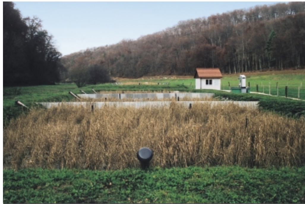
Une vue d'ensemble de la station avec le premier niveau de filtres, le petit bâtiment d'exploitation, le dégrilleur (à dr.) et plus loin le deuxième niveau de filtres également planté de roseaux.
